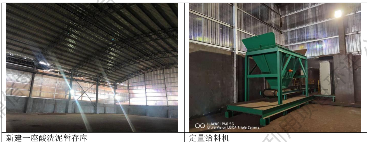
图 7.1-1 本次新建一座酸洗泥暂存库
